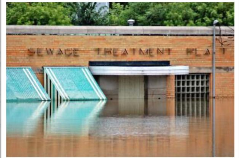
Abrumadoras tormentas/colapso de sistemas de contención de aguas residuales
