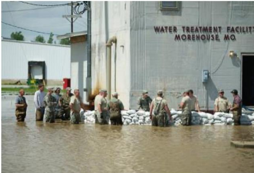
Sistemas de tratamiento y distribución de agua colapsados
